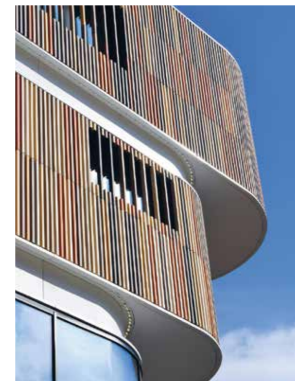
Budynek Minto, Mönchengladbach, Niemcy
